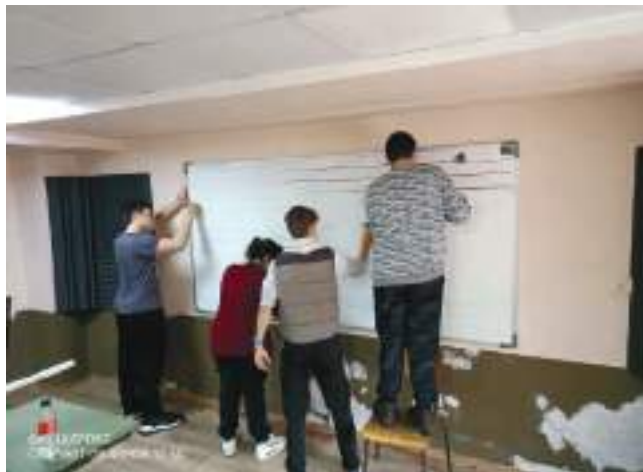
Изграждане на аудио-визуалното студио
